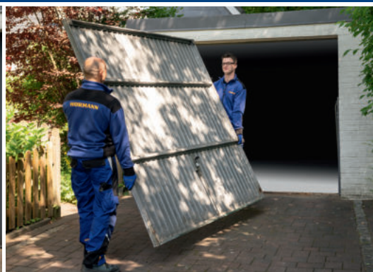
Ausbau und umweltgerechte Entsorgung
