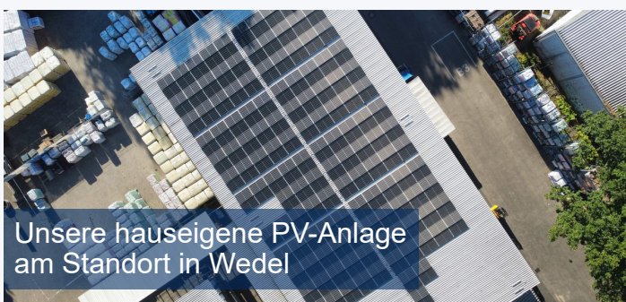
10,56 kWp Anlage für einen Neubau in Wedel
